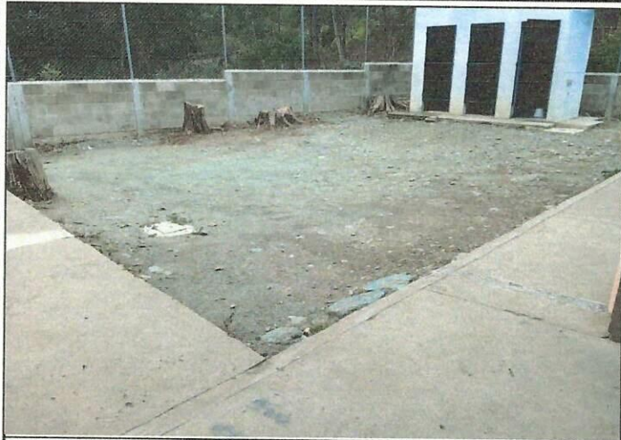
Foto1: MEJORAMIENTO DE AULA CON ESTRUCTURA DE TECHO, TIPO PORTICO, CON PISO Y CIRCULADO CON MALLA
