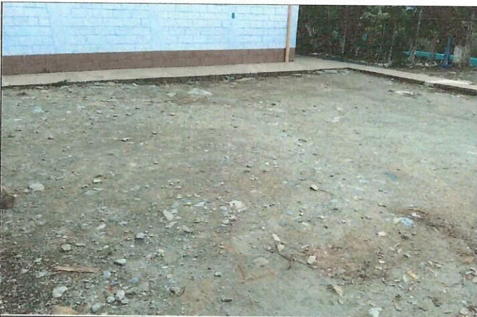
Foto 3: MEJORAMIENTO DE BANQUETA.
